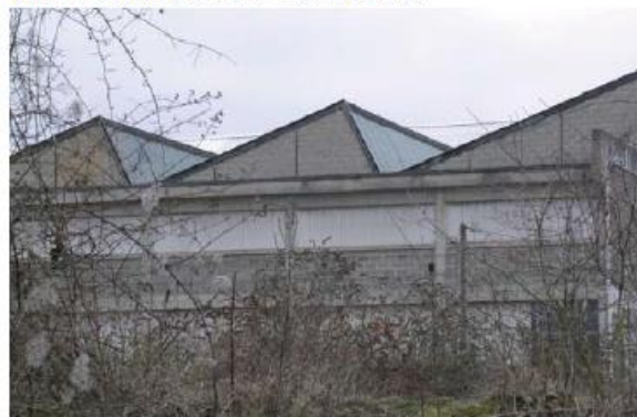
Toiture en sheds (prise de vue - Chemin de Halage)
