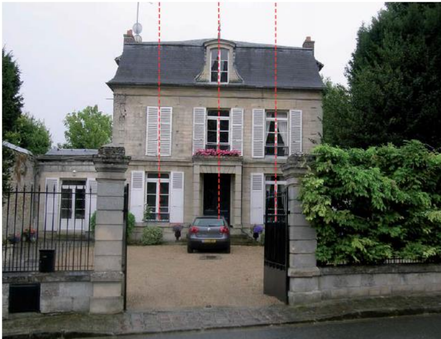
Alignement et symétrie des ouvertures de façade
