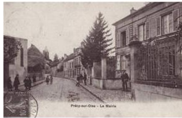
Ancienne mairie, rue Gaston Watteau
