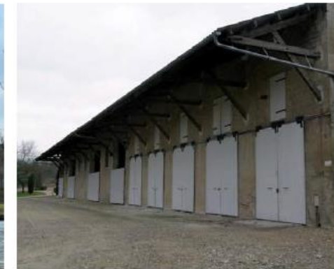
Hangar agricole avec toiture à larges débords faisant office de auvent (prise de vue - route de Boran)
