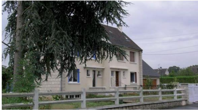
Maisons accolées R+I+C (prise de vue - rue du Clos de la Chapelle)
