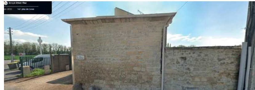
VUE ACTUELLE DU MUR PATRIMONIAL S'ARRÊTANT AU PIGNON DE LA CONSTRUCTION
