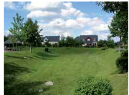
Grand bassin d'infiltration
