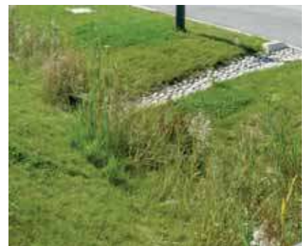
Noue drainante en bord de voirie
