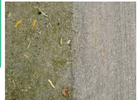
AVANT - APRÈS Dés herbage mécanique de stabilisé
