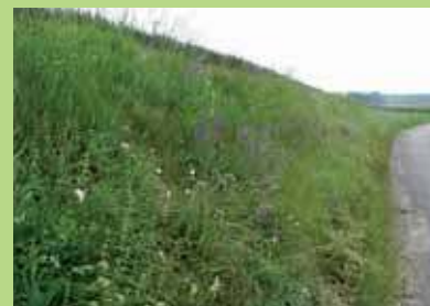
Talus large et en déblais + végétation variée = intérêt marqué
